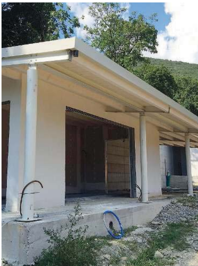
Frazione Mattina. Proseguono i lavori per completare la sede
